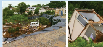
Fig. 3 - Erosão que destruiu 2 residências e danificou 23 e em São Thiago- MG (Fonte: Tv Globo, 2017, https://g1.globo.com/mg/sul-de-minas/noticia/2017/02/imagens-mostram-momento-em-que-casas-desabam-com-chuva-em-mg.html ).
