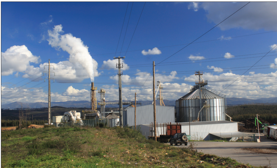
Fot. 4 - Central de Biomassa de Mortágua. Outro setor, no qual também se destaca a chaminé a expelir fumos resultantes da combustão (Fotografia de João Luís Fernandes, tirada a 09-10-2020).
