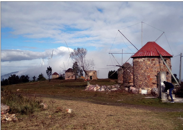
Fot. 15 - Moinhos requalificados em Portela de Oliveira, contíguos ao parque eólico. Em segundo plano, notam-se as pás dos primeiros geradores deste alinhamento ao longo da cumeeada (Fonte: Ana Maria Cortez Vaz, 2011).
