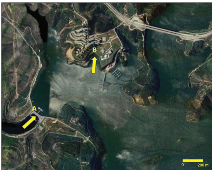
Fig. 5 - Localização da barragem da Aguieira (A) e empreendimento turístico (B) nas margens da albufeira (Fonte: adaptado a partir do Google Maps ).
