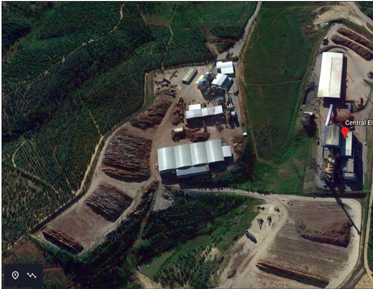
Fig. 6 - Central de Biomassa de Mortágua (Fonte: adaptado a partir do Google Maps ).
