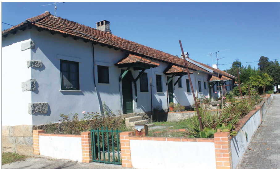
Fot. 5 - Habitações construídas no complexo mineiro da Urgeirica (Fotografia de João Luís Fernandes, tirada a 08/11/2019).
