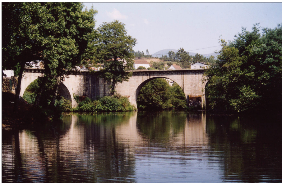
Fot. 6 - Pormenor, tomado de jusante, da curiosa Ponte das Três Entradas, na confluência dos rios Alva (arco da esquerda) e Alvoco (arcos da direita) (Fonte: Arquivo do NICIF).
