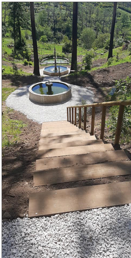
Fot. 14 - Vista sobre os lagos do Jardim Botânico do Santuário de Nossa Senhora das Preces, após as obras de reabilitação que se seguiram ao incêndio de outubro de 2017 (Fonte: Arquivo do NICIF).
